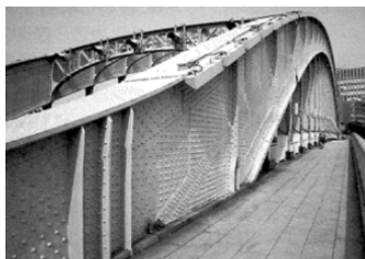
写真-9 永代橋アーチリブのリベット
