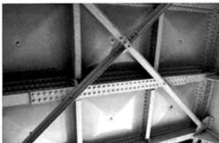
写真-6 永代橋のバックルプレートを使用した床版
